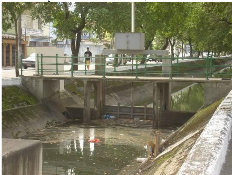
Figura 5. Canal de Drenagem.
