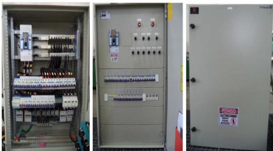
Figura 3 - Montagem de um painel elétrico do tipo TTA/PTTA.
