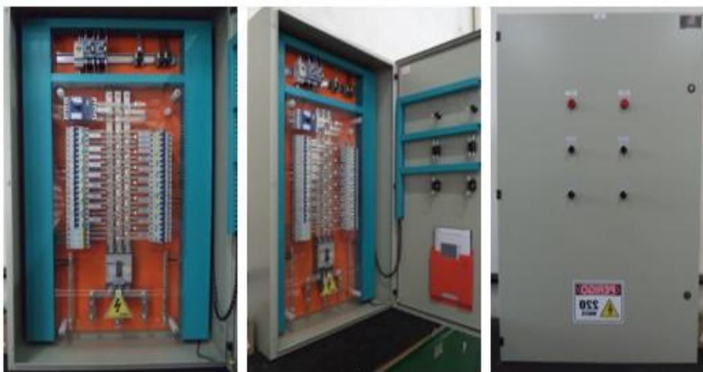
Figura 4 - Montagem de um painel elétrico do tipo Convencional
