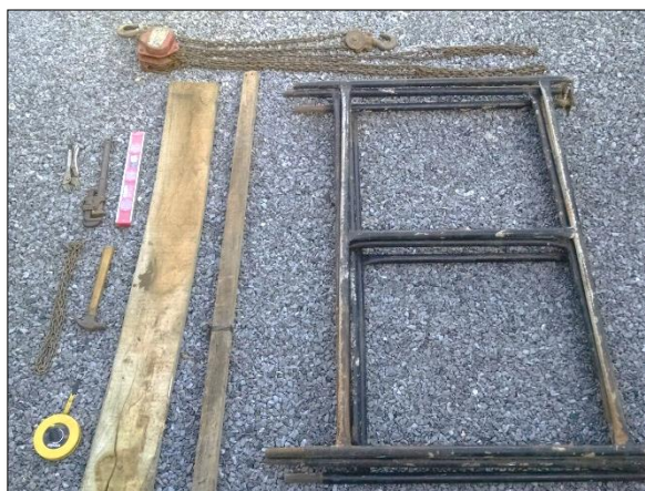
Figura 5 - Equipamentos e materiais auxiliares. Fonte: Os autores.
