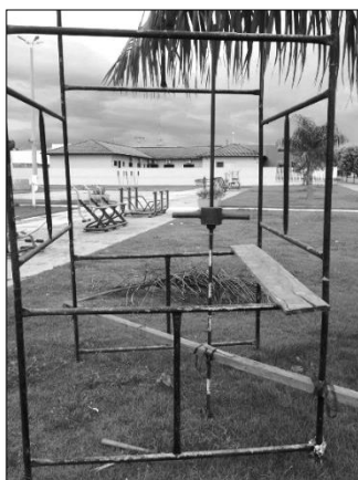
Figura 8 - Montagem do equipamento. Fonte: Os autores.
