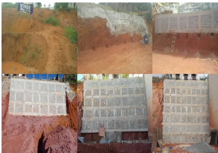
Figura 10 - Sequência executiva construção da face em alvenaria de blocos de concreto. Fonte: Os autores.
