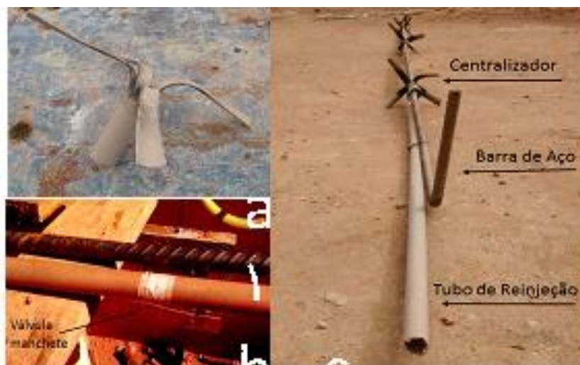
Figura 5 - Detalhes da Montagem dos Grampos. Fonte: Os autores.
