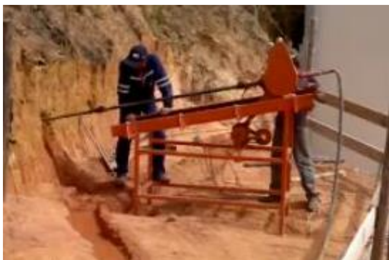
Figura 6 - Perfuratriz Rotativa utilizada. Fonte: Os autores.
