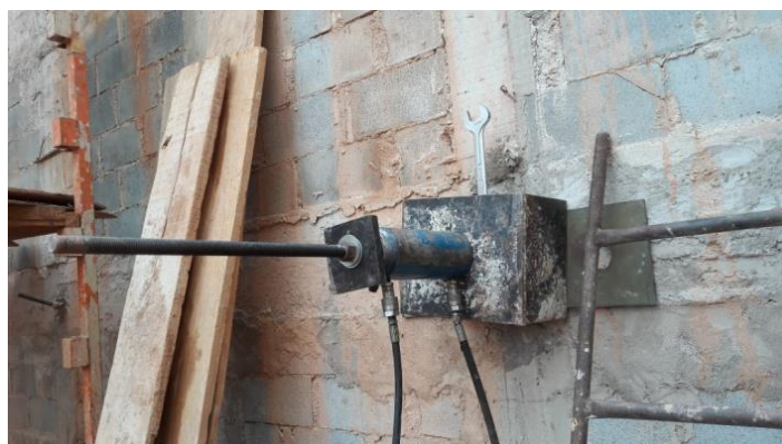
Figura 2 - Travamento do grampo à barra de ensaio. Fonte: Os autores.
