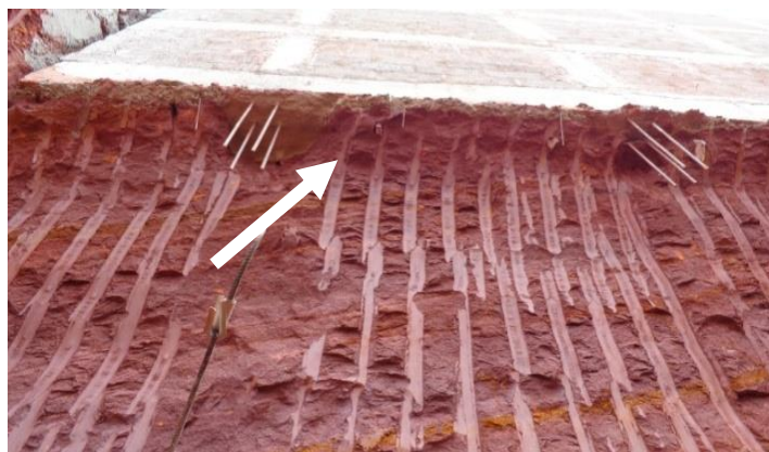
Figura 9 - Detalhe do trespasse armadura dos pilares do muro. Fonte: Os autores.
