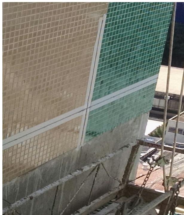
Figura 6. Preenchimento da junta horizontal e vertical com selante impermeável de elasticidade.
