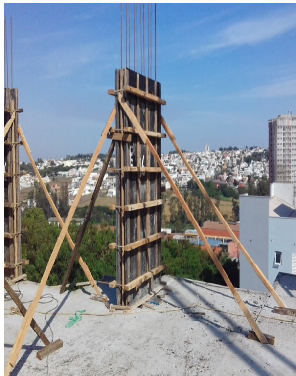
Figura 4. Fôrma executada conforme projeto e fixada ao pavimento. Fonte: Próprio Autor (2016).
