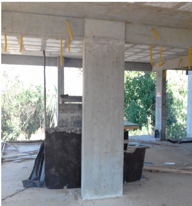
Figura 5. Fôrma removida e elementos estruturais superiores executados. Fonte: Próprio Autor (2016).
