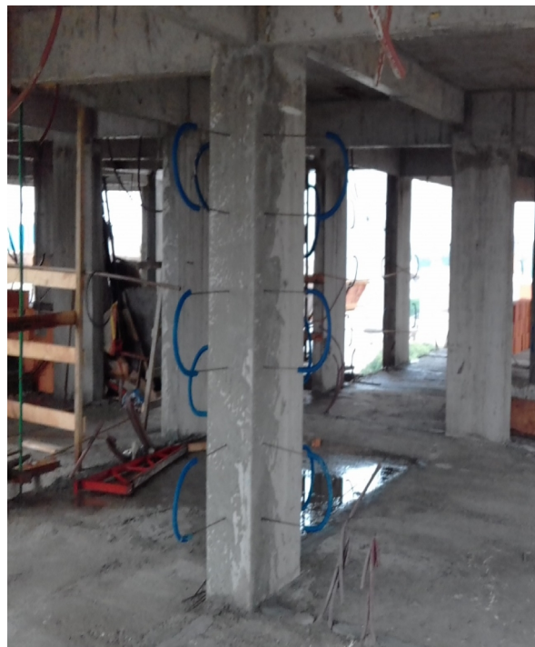
Figura 6. Ferros cabelo e chapisco de assentamento executados. Fonte: Próprio Autor (2016).
