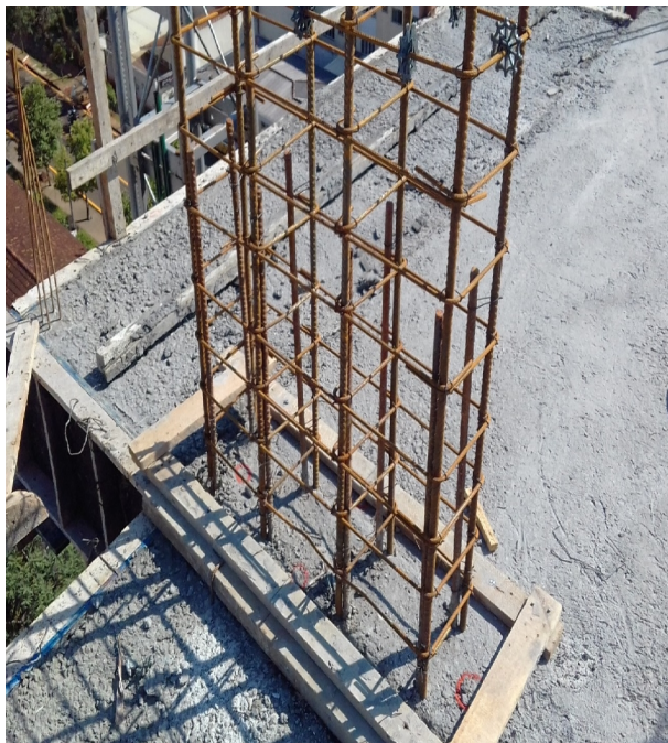
Figura 3. Gastalho executado e armadura posicionada e fixada à ancoragem. Fonte: Próprio Autor (2016).
