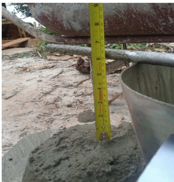
Figura 2. Slump Test realizado “in loco”. Fonte: Imagem obtida pelo autor em uma das obras analisadas na pesquisa.
