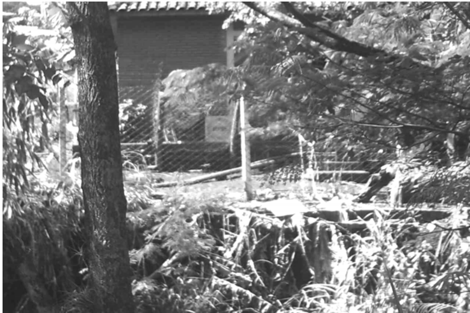
Figura 1: Moradia com risco de deslizamento
